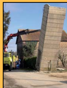
Démolition d'un « poste-tour » à Houx
