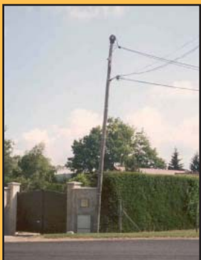
Le SDE 28 reste vigilant quant à la politique de renouvellement des ouvrages du concessionnaire.
